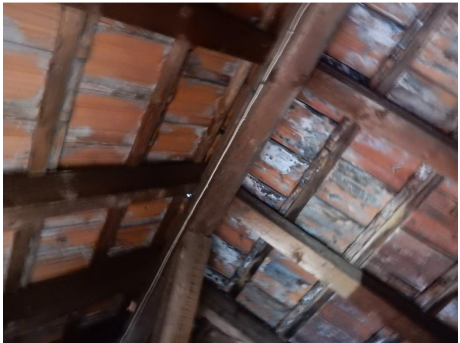
Foto 5: ... und im Bereich des Dachstuhls.
