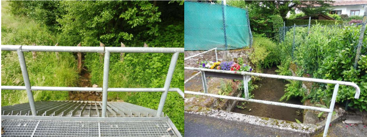
Abbildung 20: Einlaufbauwerk am Forellenbach (li.), kanalisierte Bachverlauf im Bereich Bachweg (re.) (Quelle: Fotodokumentation)
