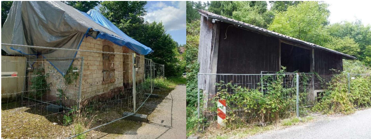
Abbildung 24: Altes „Wärterhäuschen“ und Außenbereich/Schuppen bei der Tongrube (Quelle: Fotodokumentation)
