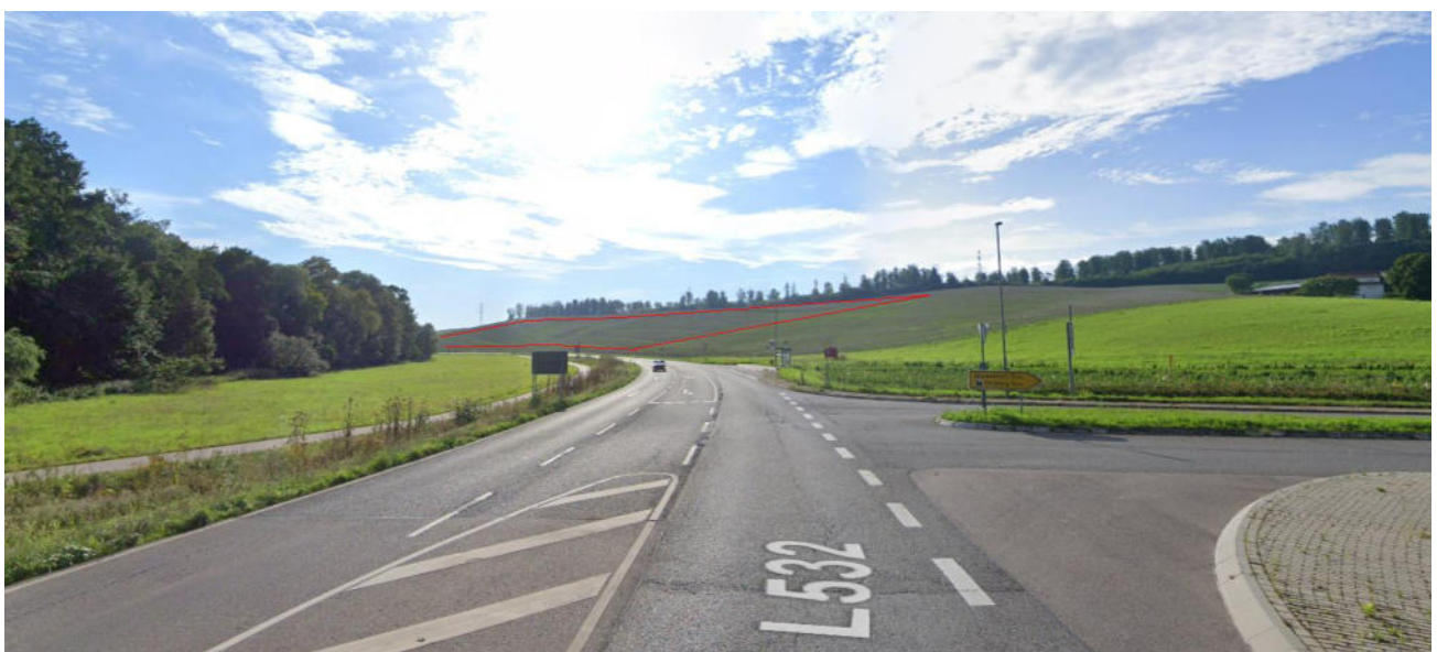
Bild 4.7.2: Situation im Bereich der Einmündung K4200 auf die L532 (Quelle: Google StreetView, August 2023, Ausschnitt)
