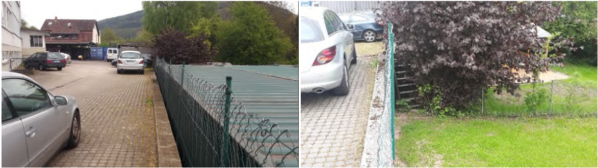
Bild 11 und Bild 12: südliche Grenze des Plangebiets mit Umzäunung und Stützmauer
