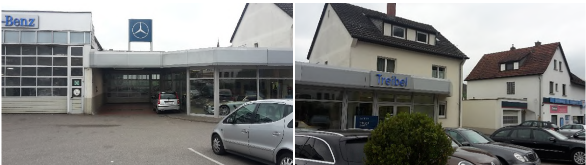
Bild 7 und Bild 8: Werkstatt, Verkauf und Stellplätze im Norden; Blick auf integriertes Wohnhaus Über eine rampenartige Zufahrt im Westen des Grundstücks konnte der Hinterhof erreicht werden (siehe Bild 5). Hier waren weitere Stellplätze angeordnet sowie diverse Lagerflächen und Unterstände für den Betriebsablauf und die Lagerung (siehe Bild 9 und 10).
