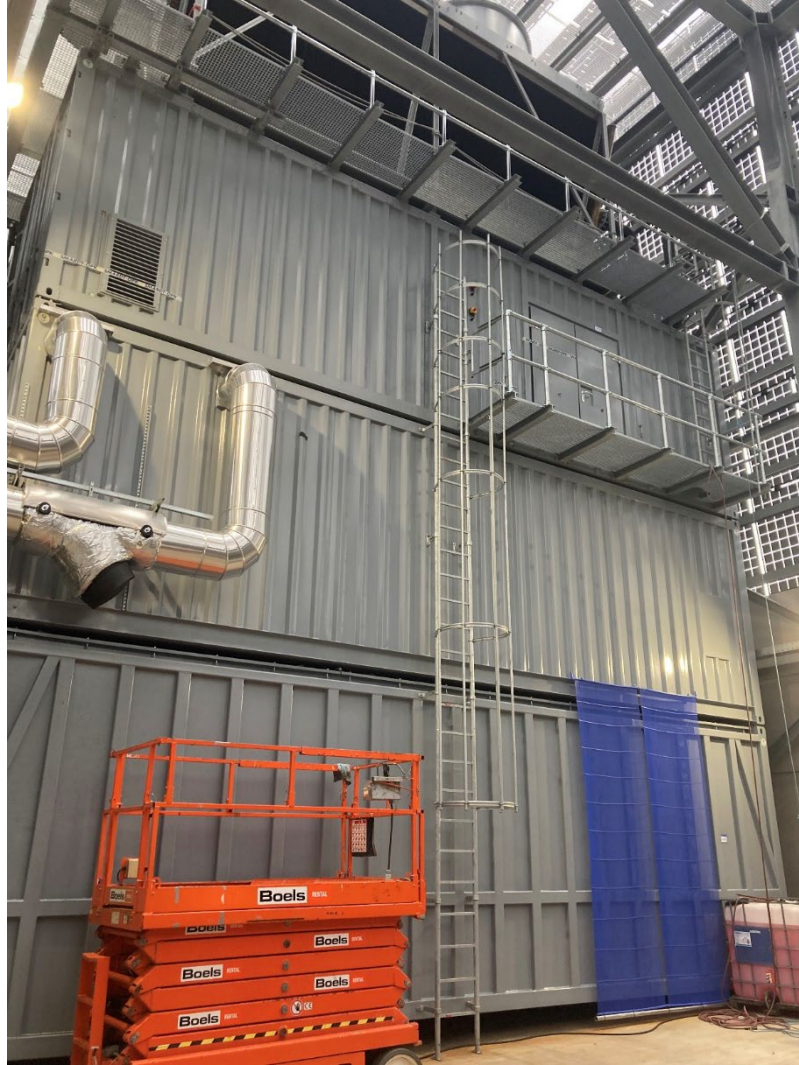
Kälteturm 2: Zugang KKM-Container und Rückkühler
